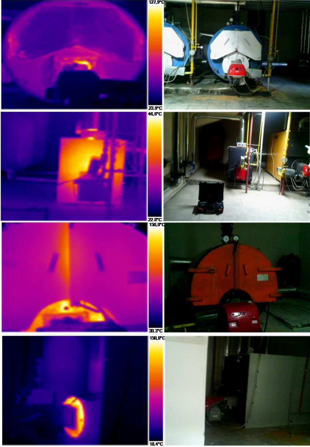
Şekil 5: Kazanlarda termal kamera görüntüleri, [1]
