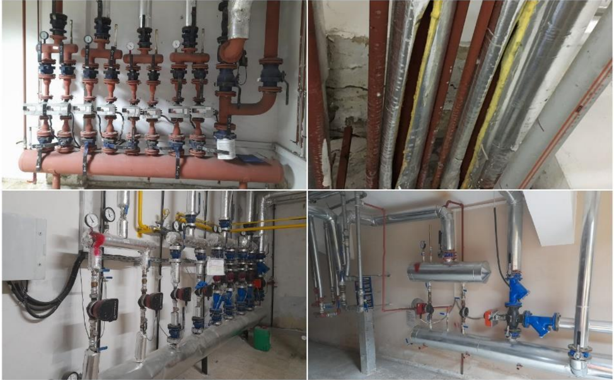
Şekil 9 Isıtma Mekanik Tesisatı, [1]
