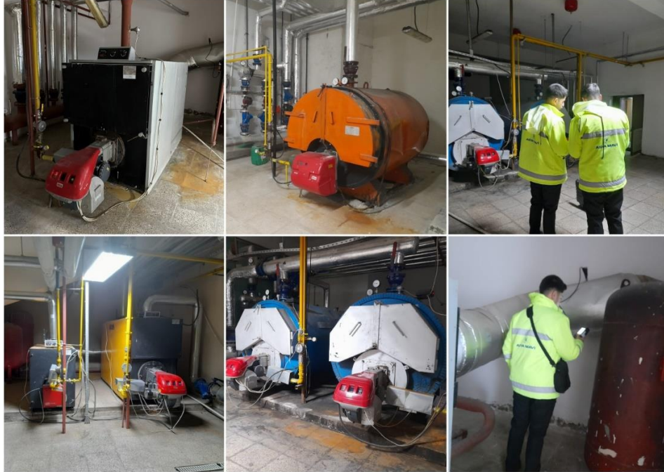
Şekil 4: Yer Tipi Sıcak Su Isıtma Kazanları- Isı Merkezleri, [1]
