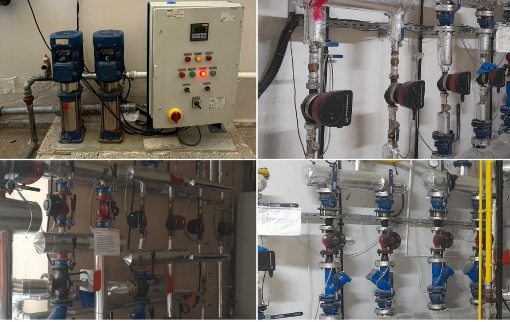
Şekil 18 Sirkülasyon Pompa Sistemleri, [1]
